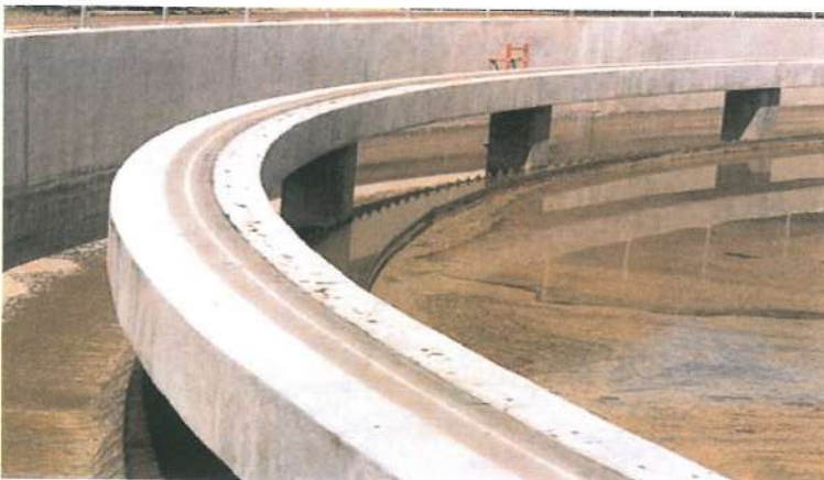
تصویر ۱- سایش شدید سطح باربر برای دستگاه تمیز کننده ی رسوبات فاضلاب
